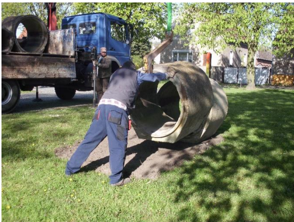
Zwischenzeitlich wurde die Betonröhre aufgebaut, gesäubert, gespachtelt und grundiert.
