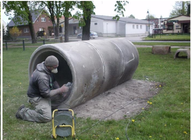
Zwischenzeitlich wurde die Betonröhre aufgebaut, gesäubert, gespachtelt und grundiert.
